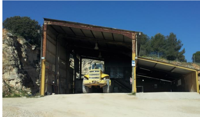
Imagen 13. Detalle de la nave taller.
