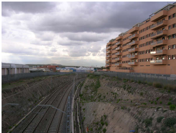
Sentido estación de Rivas-Urbanizaciones
