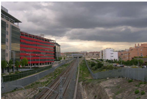
Sentido estación de Rivas-Urbanizaciones
