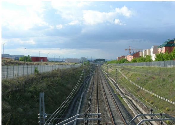
Sentido estación de la Poveda
