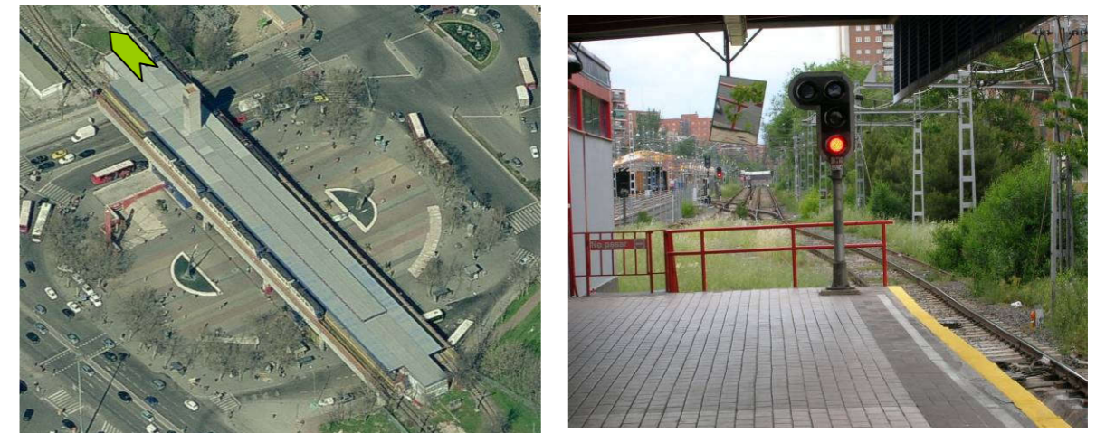
Estación de Aluche (ref. Bing Maps y visita de campo )
