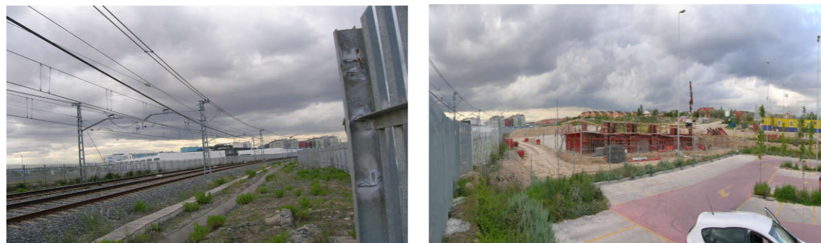
Proximidades de la estación Rivas-Vaciamadrid (Sentido estación de Rivas-Urbanizaciones) (ref. Ortofoto PNOA y visita de campo )
