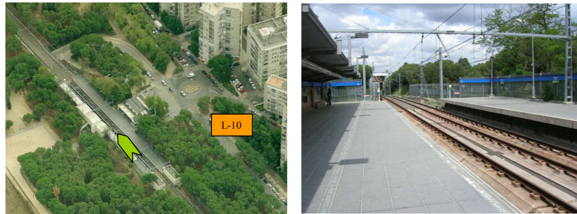
Proximidades de la estación de Batán (sentido estación de Lago) (ref Bing Maps y visita de campo )
