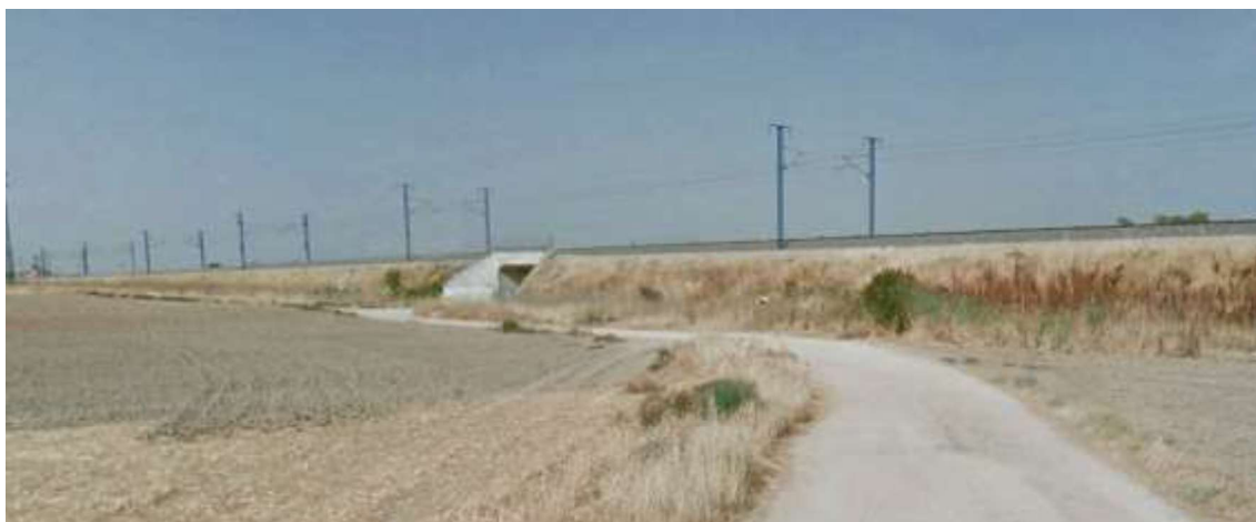
Ilustración 9. Línea de AVE afectada por el tramo subterráneo de la línea de evacuación de 15 kV (vista de la ubicación del cruzamiento Línea MT-Línea AVE desde el Camino de los Hueros)
