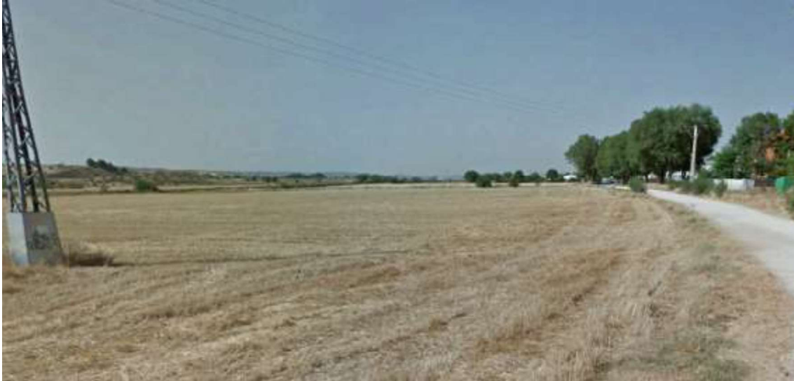
Ilustración 12. Parcelas afectadas por el trazado subterráneo de la línea de evacuación de 15 kV (Vista desde la intersección del Camino de los Hueros con el Camino de la Isabela)
