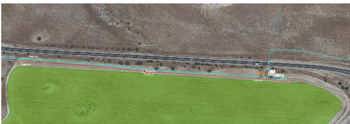
Figura 6: Canalización del Canal de Isabel II junto al lindero norte de la planta. Fuente: Proyecto Solar 3 Rayas, OSPREL RENOVABLES S.L.
