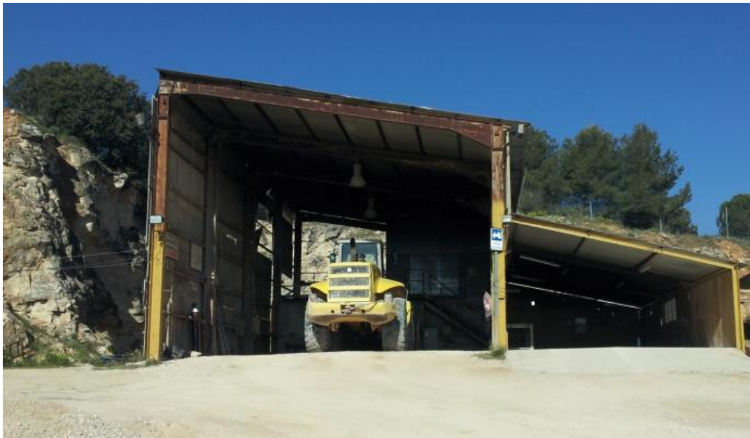
Figura 8. Detalle de la nave taller
