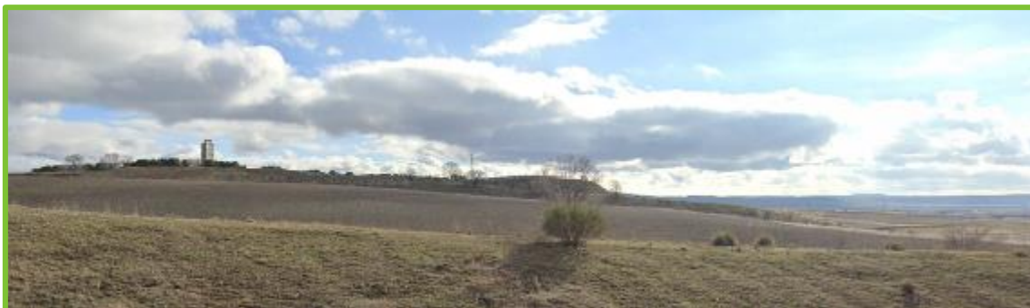
Figura 9.7 – Vista del CTR desde autovía M-50.
