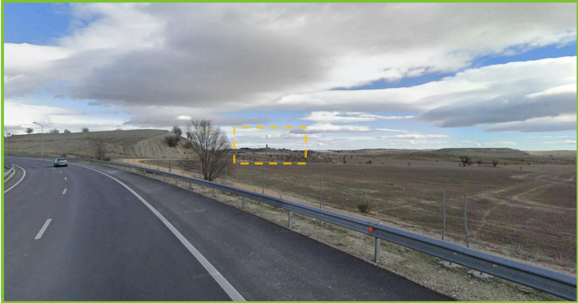
Figura 3.15 – Vista al este desde la vía M-50 con el CTR al fondo.
