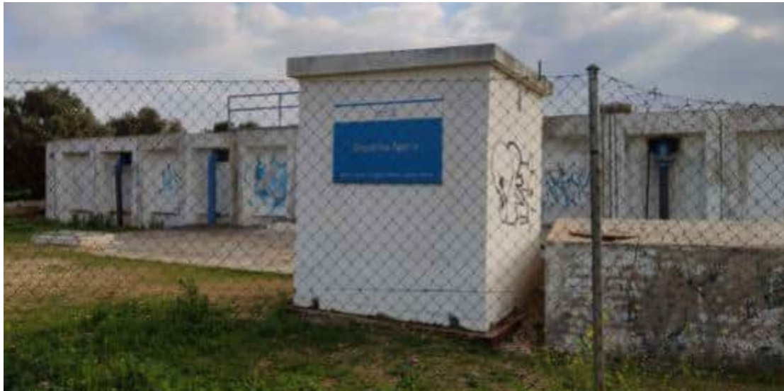
Depósitos de agua que abastecen a Ajalvir. Fuente: Elaboración Propia
