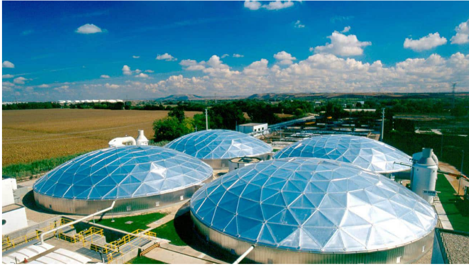
Vista de pájaro de la EDAR de San Fernando de Henares
