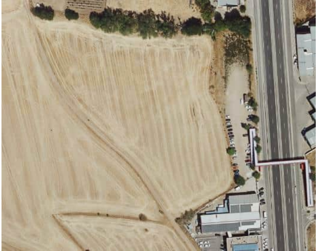
Vista área de las obras en ejecución en el Sector R-1. Fuente: Ortofoto CM de 2022. Visor topográfico de la CAM
