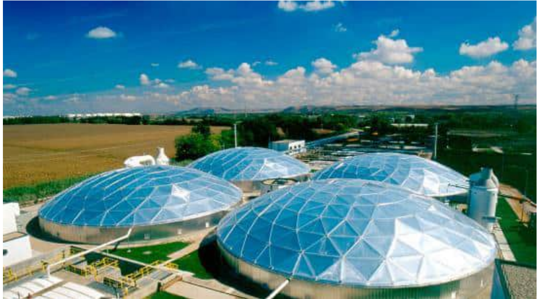
Vista de pájaro de la EDAR Casaquemada, en el municipio de San Fernando de Henares
