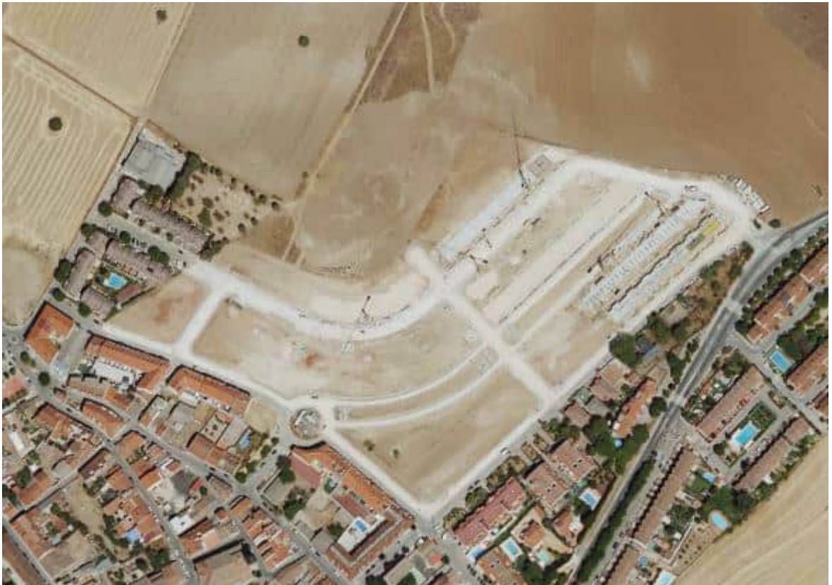
Vista área de las obras en ejecución en el Sector R-1. Fuente: Ortofoto CM de 2022. Visor topográfico de la CAM
