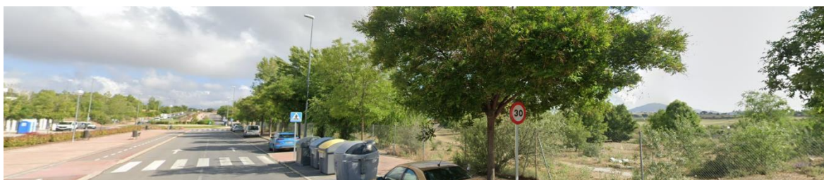
Fig. Vista actual de uno de los pasos de peatones existentes en la Avenida de Cristóbal Colón en el frente de la parcela DC-3
