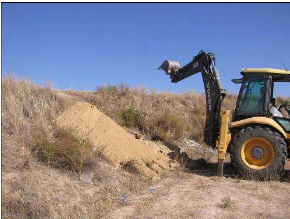
Realización de calicata al pie de una de las zonas de vertido de escombros
