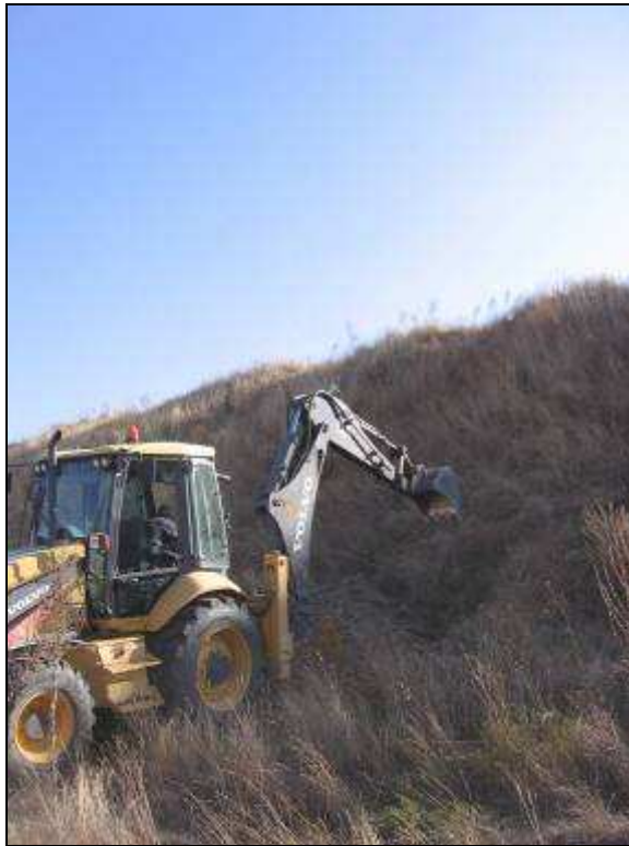
Realización de calicata al pie de una de las zonas de vertido de escombros
