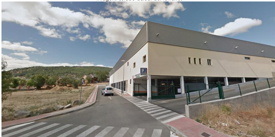
Imagen: estado actual desde el punto más al Noreste del ámbito, hacia el punto más al Noroeste de este.
