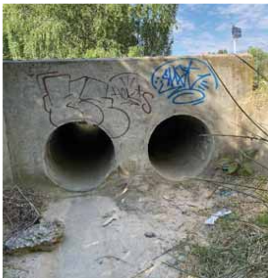
Obra de drenaje transversal bajo camino peatonal. Fuente: fotografía propia
