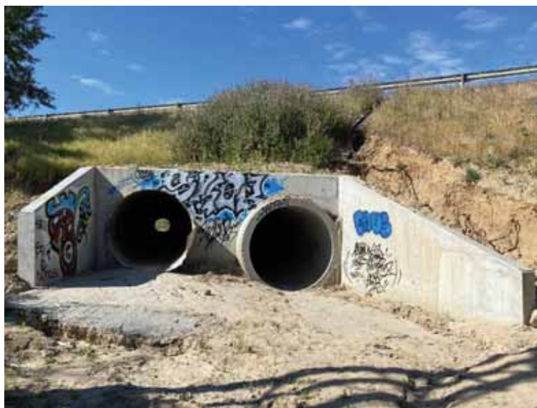
Fotografía de la obra de drenaje bajo la carretera M-503. Fuente: fotografía propia
