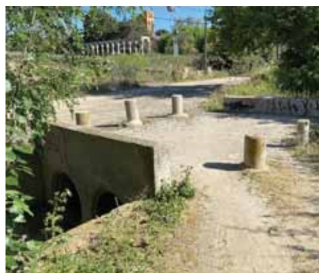
Obra de drenaje transversal bajo camino peatonal. Fuente: fotografía propia
