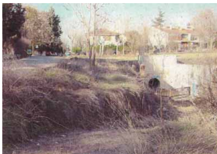
Fotografía del arroyo aguas abajo del área de actuación, observándose el inicio del entubamiento bajo el núcleo urbano. Fuente internet
