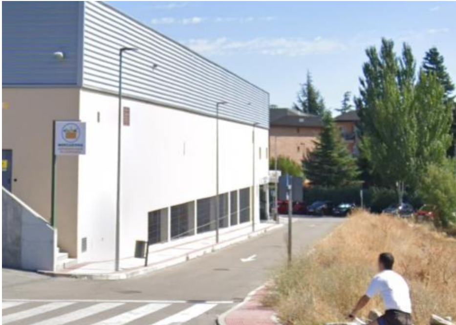
Figura. Fotografía del alumbrado existente en la calle que linda al norte del Sector.
