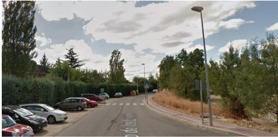
Figura. Fotografía del alumbrado existente en el Camino de Los Linares
