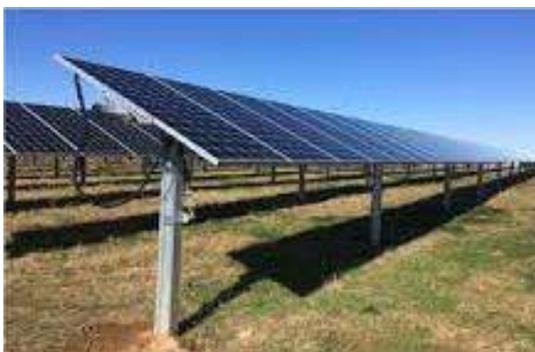
Imagen 3. Estructura giratoria a un eje
