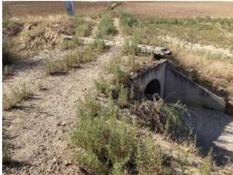
Imagen 8. Obra drenaje en zona de paso
