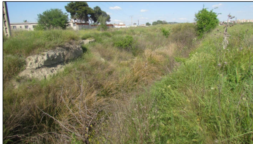
Figura 37. Arriba, obra de salida del colector bajo la cañada actual nacedero del barranco de Valdeculebra. Abajo, encauzamiento de dicho arroyo. UA18.05 Valdemingómez.
