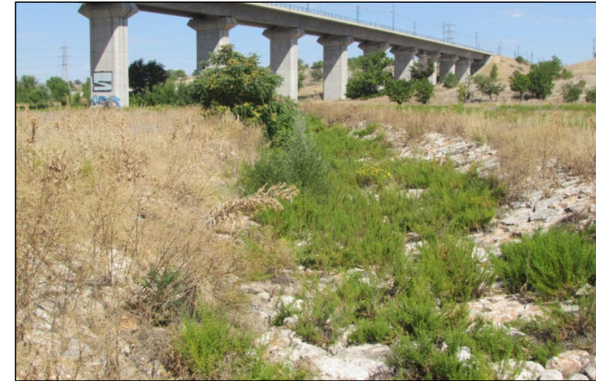
Figura 36. Cauce del arroyo de Los Migueles aguas abajo del viaducto del AVE
