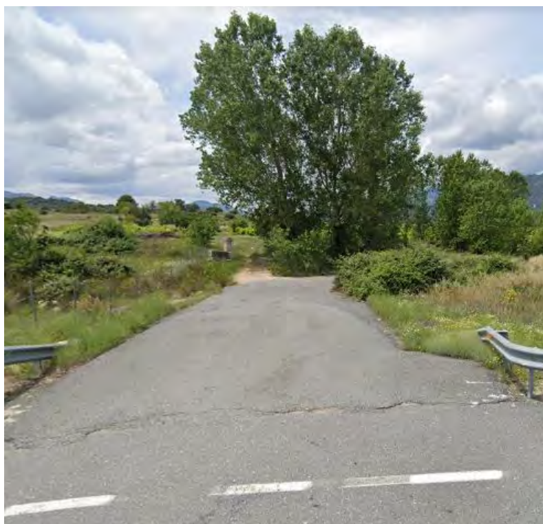
Imagen 1.1.4.12.c. Visibilidad desde el punto de acceso desde la Carretera N-403.
