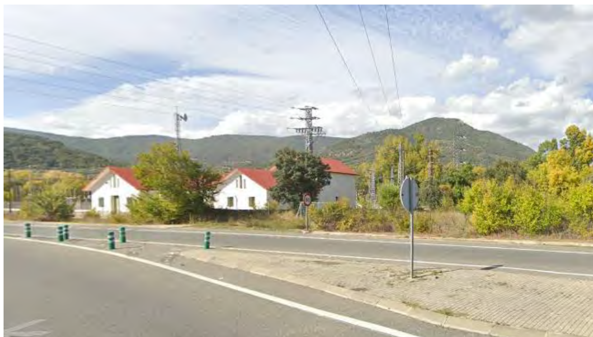
Imagen 1.1.4.10.a. ST Toros de Guisando y líneas eléctricas existentes.
