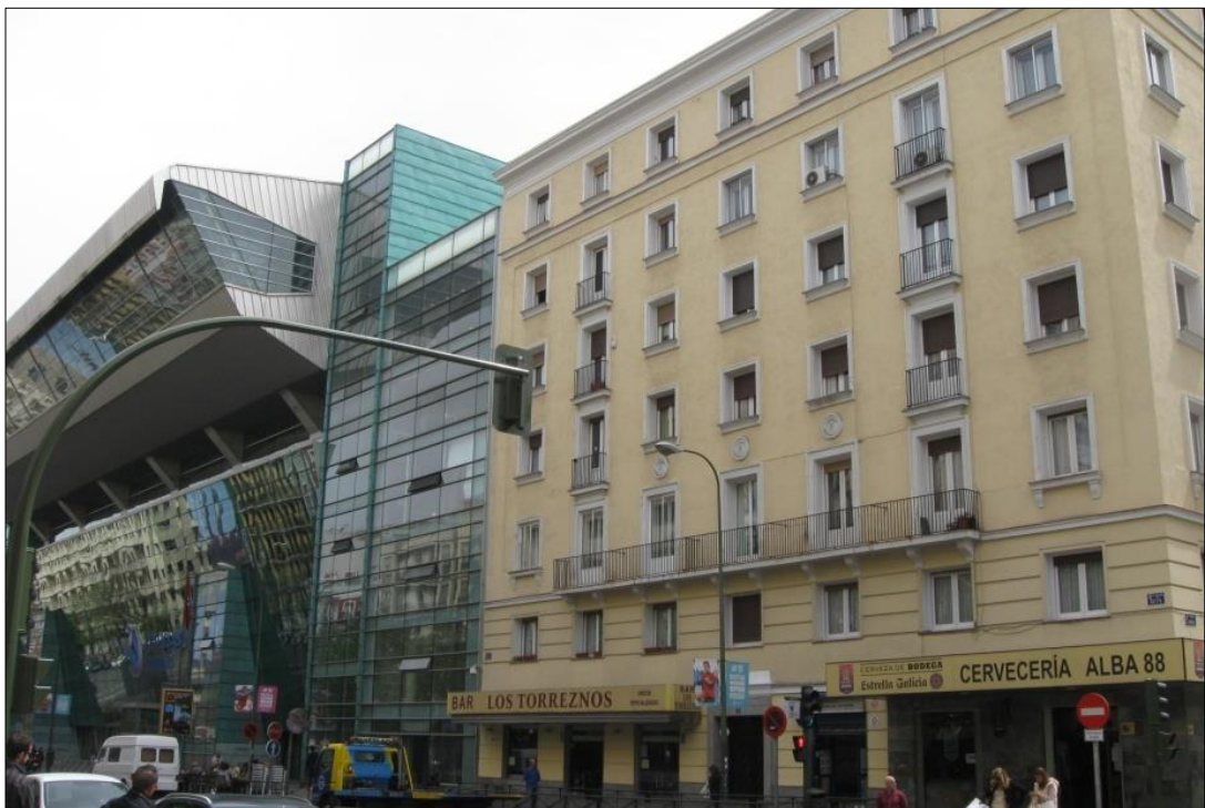
Imagen 3.1.g. En primer término se observa el edificio de viviendas situado en la calle Goya nº88 que, si bien se encuentra dentro de la misma manzana que el Palacio de los Deportes queda fuera del ámbito de la Modificación planteada.
