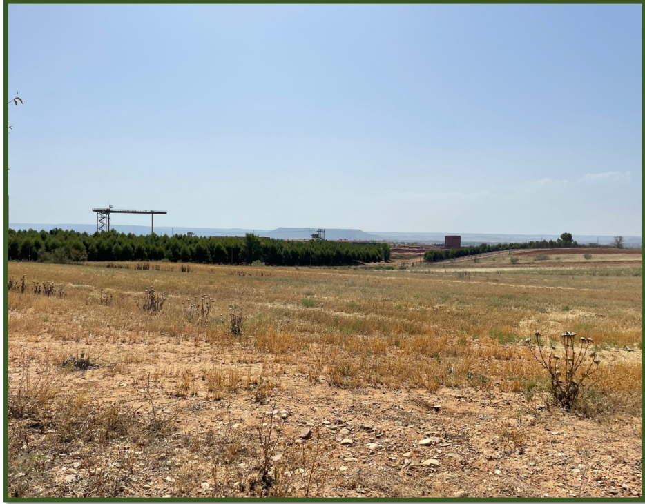
Ilustración 29. Fotografía de la situación actual del Sector S15.
