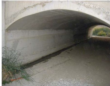
Estructura Longitudinal 2. ODT M-108. Construcción in situ abovedada 4,5 m x 2,65 m. Longitud 20 m.
