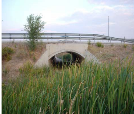
Estructura Longitudinal 2. ODT M-108. Construcción in situ abovedada 4,5 m x 2,65 m. Longitud 20 m.
