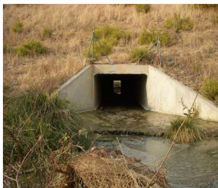
Estructura Longitudinal 1. ODT-R2. Marco 3 m x2 m. Longitud 98,5 m.
