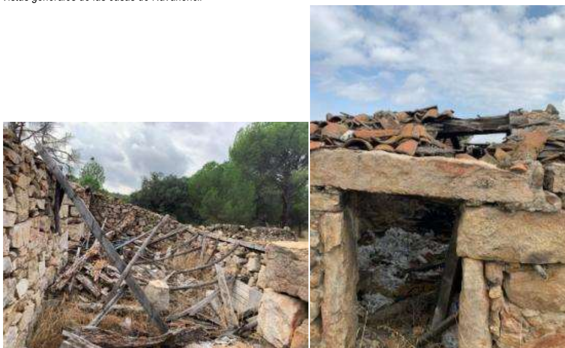
Detalle de las cubiertas, vencidas a la izquierda y aún presente a la derecha.
