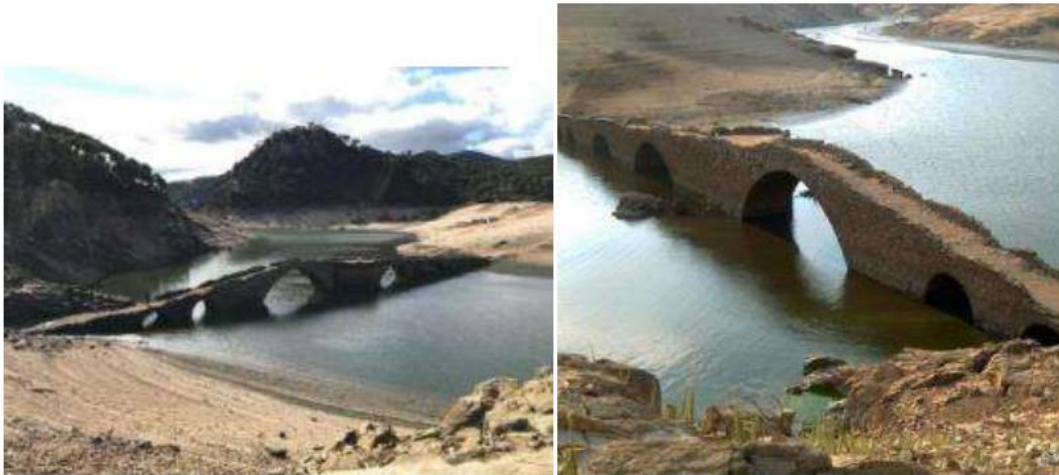
Figura 4.14.4.7.- Imágenes del puente romano
