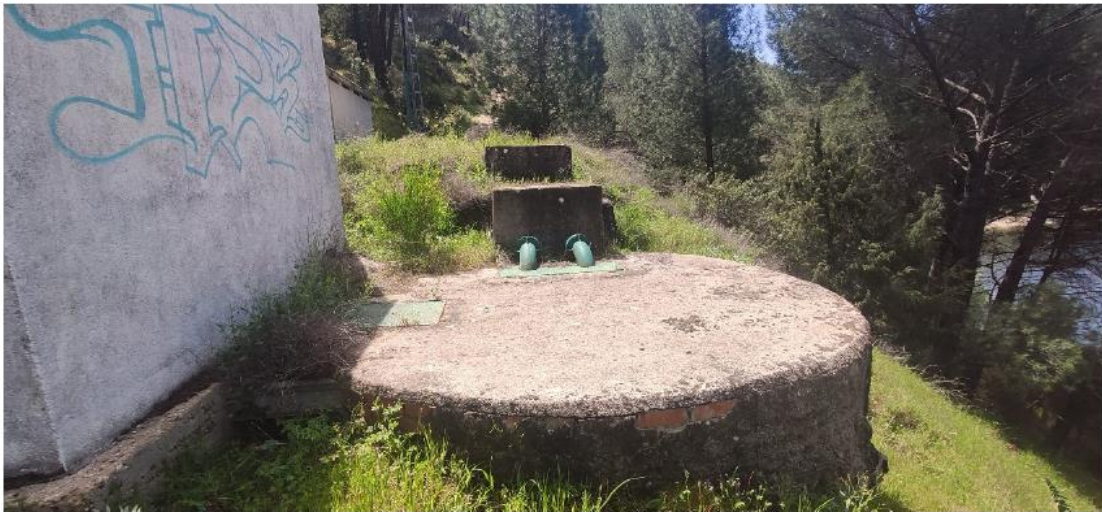
Imagen. Pozo de captación
