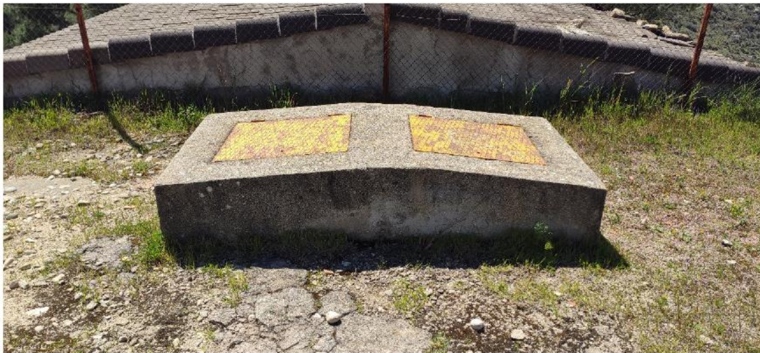
Figura 4.14.3.3.- Depósito de agua. (Fuente; Plan de autoprotección contra incendios forestales de la urbanización Canto Redondo. Inpro Medio Ambiente, S.L.)
