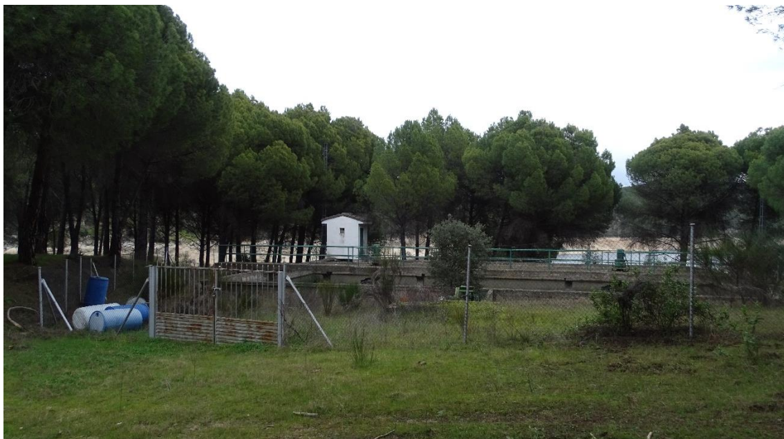
Figura 4.14.3.4.- Depuradora existente junto al embalse.
