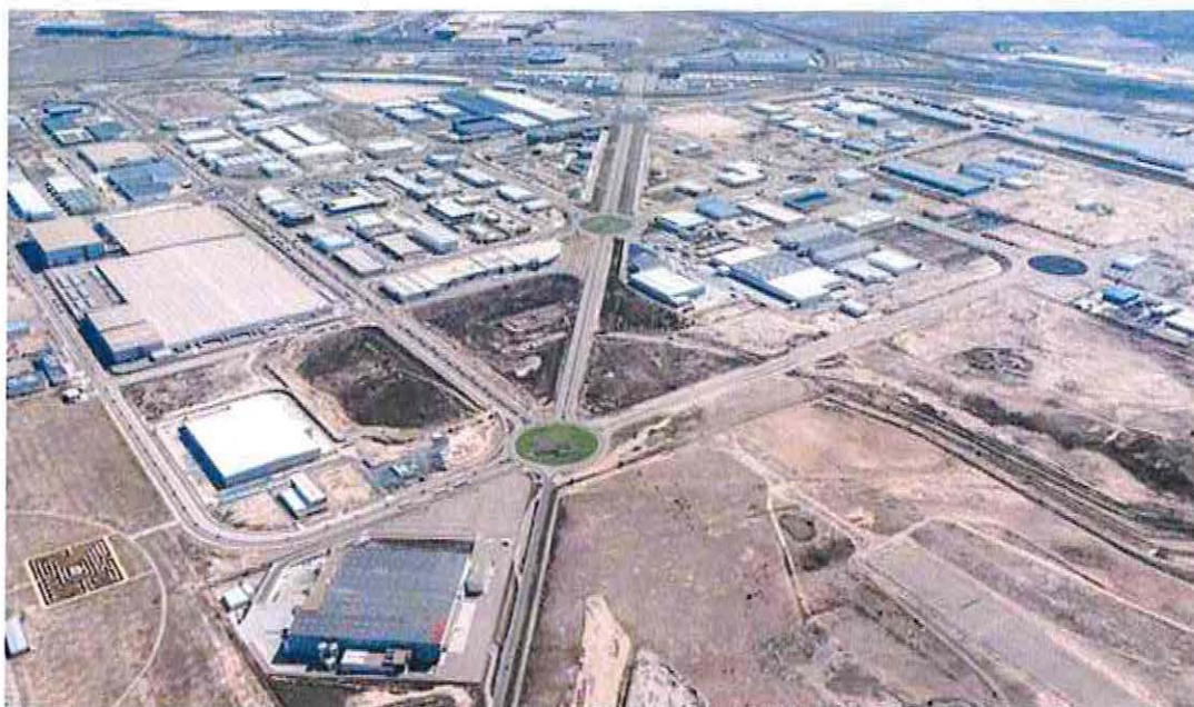
Imagen. Vista aérea de la Plataforma Logística PLAZA (Zaragoza)
