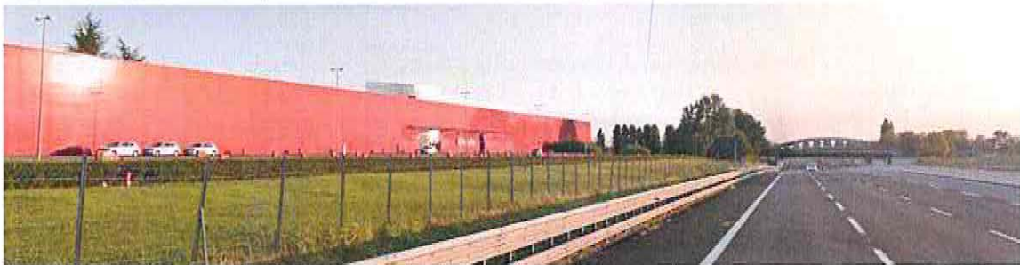
Imagen: Fachada continua exterior en polígono. Parque tecnológico Kilometro Rosso (Bérgamo-Italia) (Jean Nouvel 2007)
