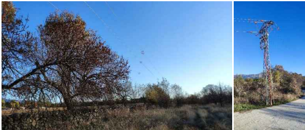
Figura 86. Línea eléctrica paralela a la carretera de Torrelaguna-Escorial, frente a camping la Fresneda y junto al arroyo del Mediano (Tramo 2), 26 de octubre 2021. Fuente: elaboración propia.
