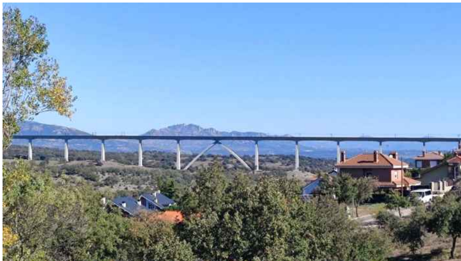
Figura 88. Viaducto Arroyo del Valle, parte de la línea Alta Velocidad Madrid – Valladolid, vista desde la urbanización Los Rancajales, 26 de octubre 2021. Fuente: elaboración propia.
