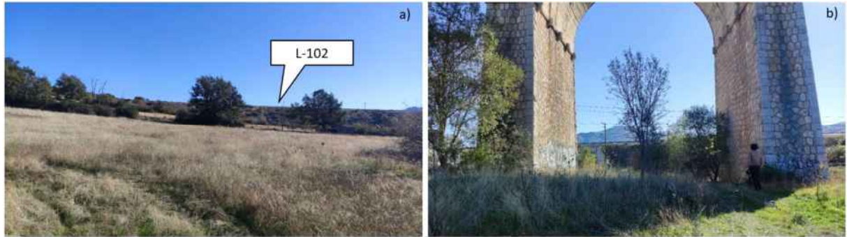
Figura 87. Línea 102 en Soto del Real (a), punto de cruce con la línea 102, a la altura del puente de los Once Ojos (b), 21 de octubre 2021. Fuente: elaboración propia.
