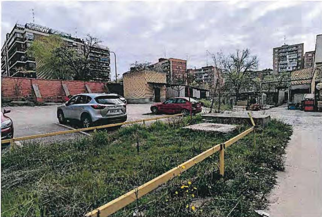
Figura 21: Vista del depósito de gasoil
