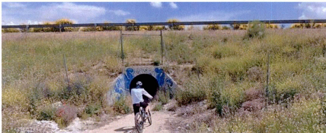
Imagen: ODT utilizado como paso subterráneo bajo M-301
