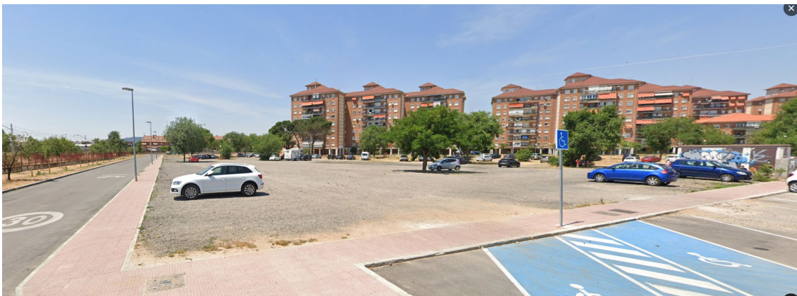
Vista del arbolado de la Parcela P-13 desde Calle Barberán y Collar. (Fuente Google Street View)
