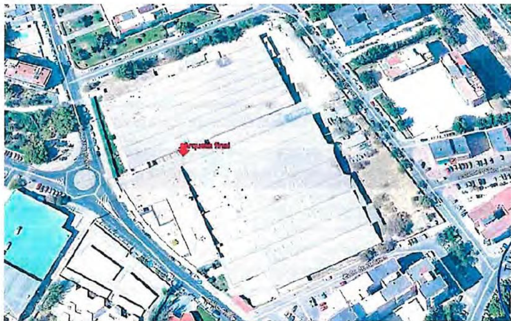
Figura 49: Ubicación del vertido de la instalación
