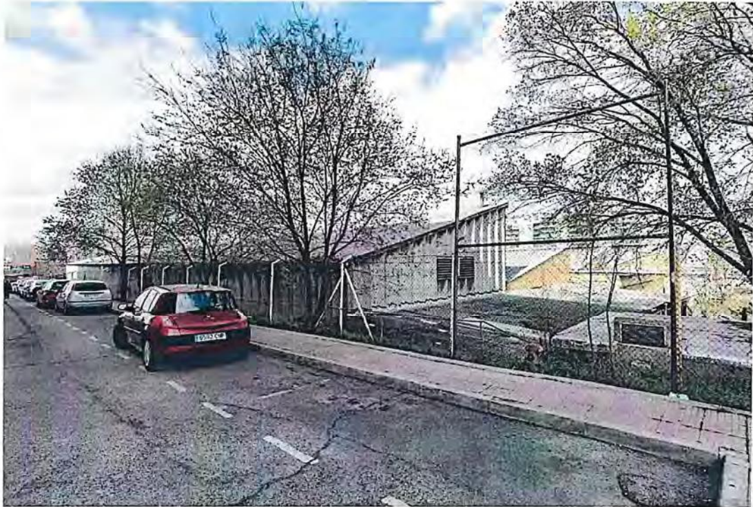
Figura 58: instalaciones actuales con cubiertas de fibrocemento. Fuente: visita a las instalaciones
