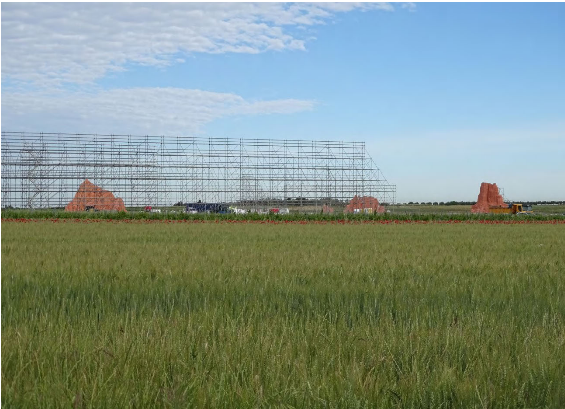
Figura 11.12. Obras para la creación de un decorado de cine en las parcelas de la zona de estudio.
