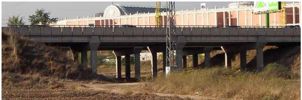
Figura. Obra de paso existente bajo la autovía A-1
