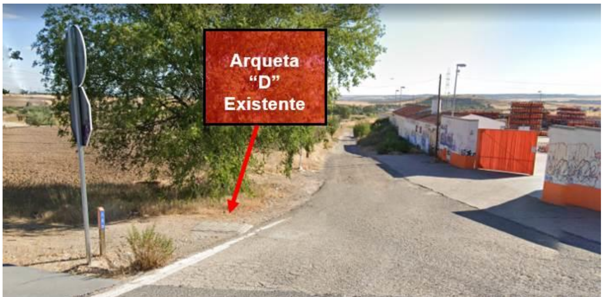
Figura: Arqueta "D" de conexión a red existente. Margen Norte de Carretera M-12
