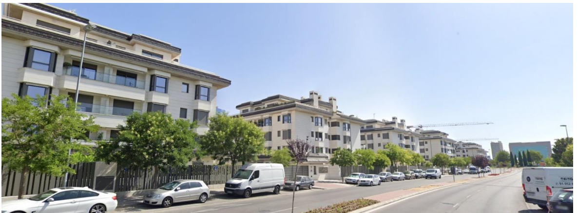
Figura. Imagen de la Av. Rafael Nadal, del barrio "El Juncal"
