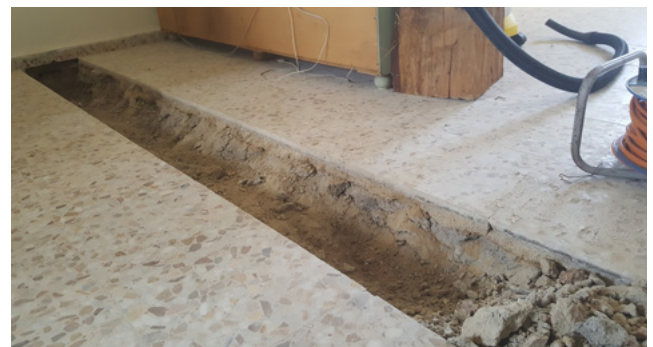
Figura 5 - Zanja para la instalación del tubo perforado y la capa de grava
