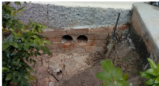
Figura 6 - Perforaciones para una de las nuevas aberturas de ventilación
