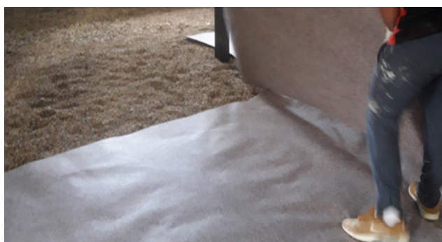
▼ Figura 9 - Colocación de la capa antipunzonante sobre la grava
