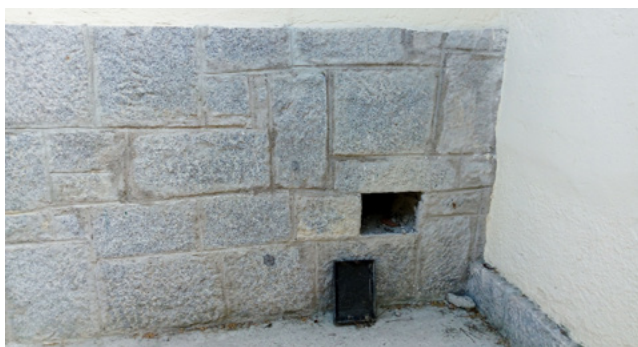
Figura 4 - Abertura de ventilación existente
