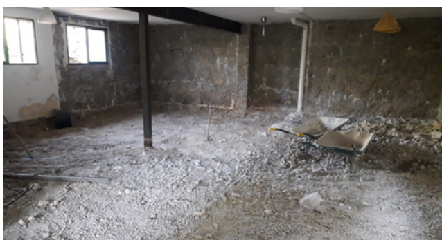
▼ Figura 5 - Demolición de la solera existente
