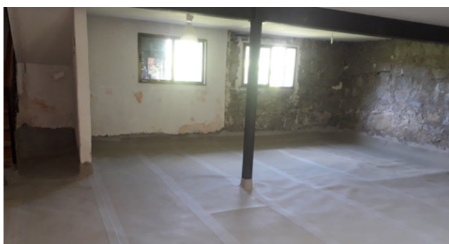
▼ Figura 13 - Lámina colocada
