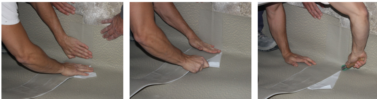
▼ Figura 10 - Sellado del solape entre dos láminas
