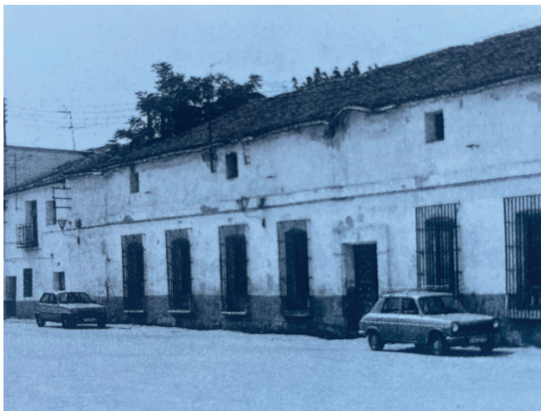
Antigua casona sede de oficinas municipales hacia 1991. En: Arquitectura y desarrollo, 1991. Fuente: Centro de Documentación de Medio Ambiente y Ordenación del Territorio.
