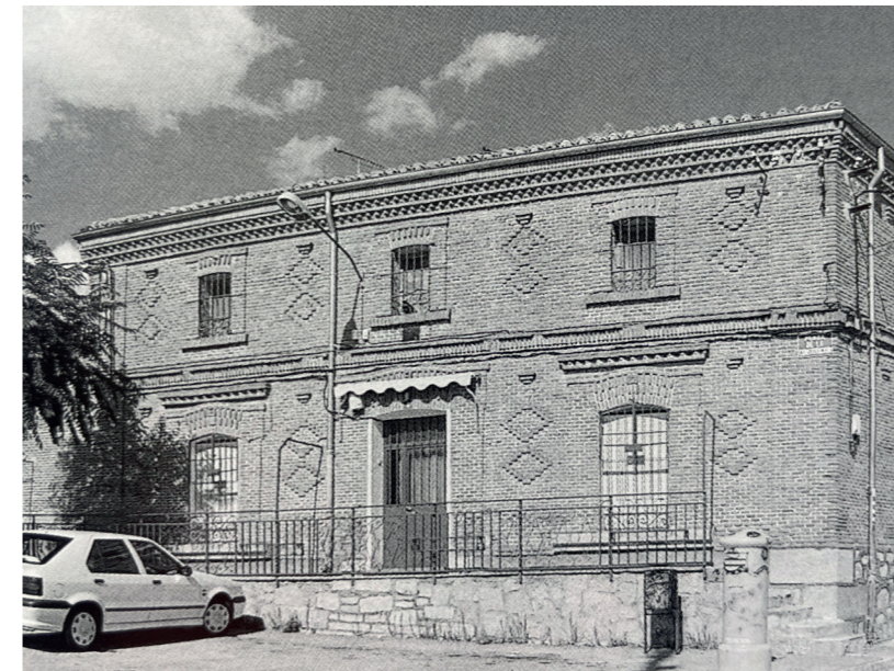
Vivienda en la plaza de la Constitución. Fotografía: Actividades y Servicios Fotográficos. En: Arquitectura y Desarrollo, 1999. Fuente: Centro de Documentación de Medio Ambiente y Ordenación del Territorio.
