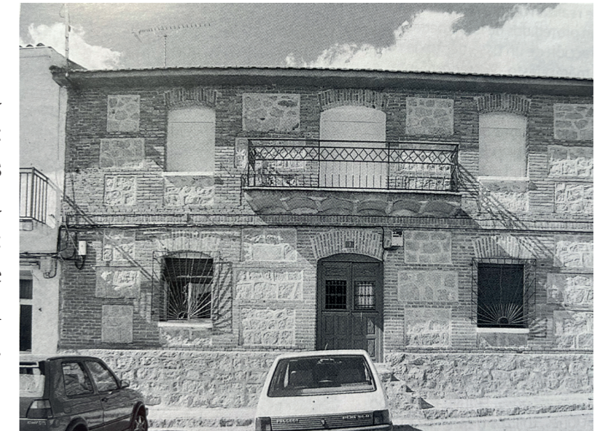
Vivienda en la plaza de la Constitución. Fotografía: Actividades y Servicios Fotográficos. En: Arquitectura y Desarrollo, 1999. Fuente: Centro de Documentación de Medio Ambiente y Ordenación del Territorio.
