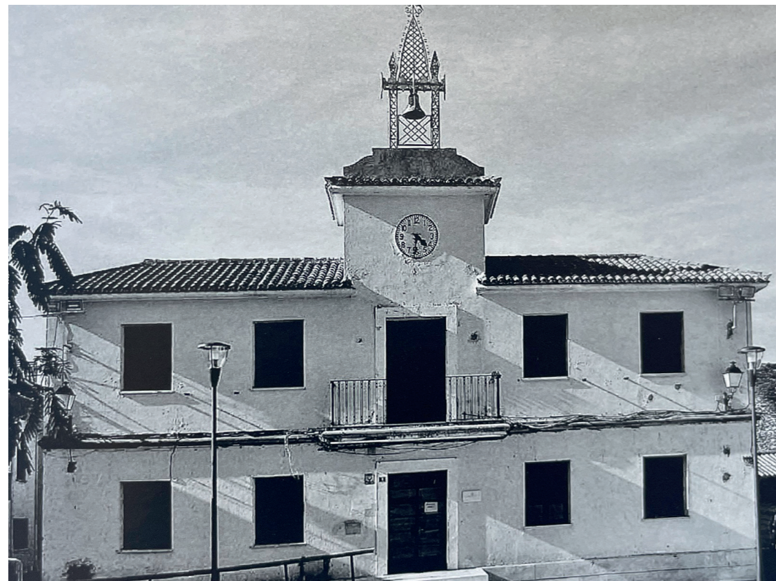
Ayuntamiento. Fotografía de Vicente Patón. En: Arquitectura y Desarrollo, 2009. Fuente: Centro de Documentación de MedioAmbiente y Ordenación del Territorio.
