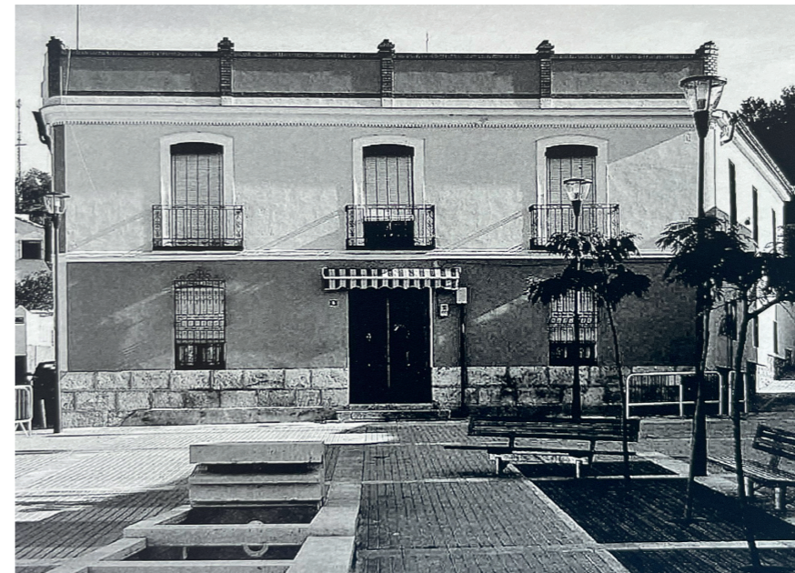
Vivienda en Plaza Mayor. Fotografía de Vicente Patón. En: Arquitectura y Desarrollo, 2009. Fuente: Centro de Documentación de MedioAmbiente y Ordenación del Territorio.
