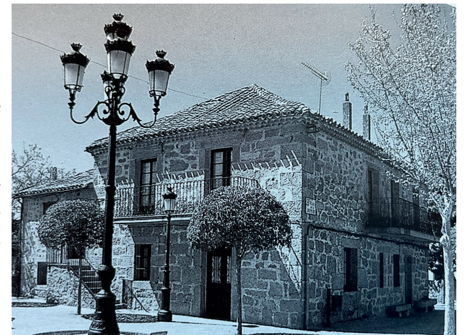
Edificio en la plaza. Fotografía: José Manuel Ablanedo. En: Arquitectura y desarrollo, 1991. Fuente: Centro de Documentación de Medio Ambiente y Ordenación del Territorio.
