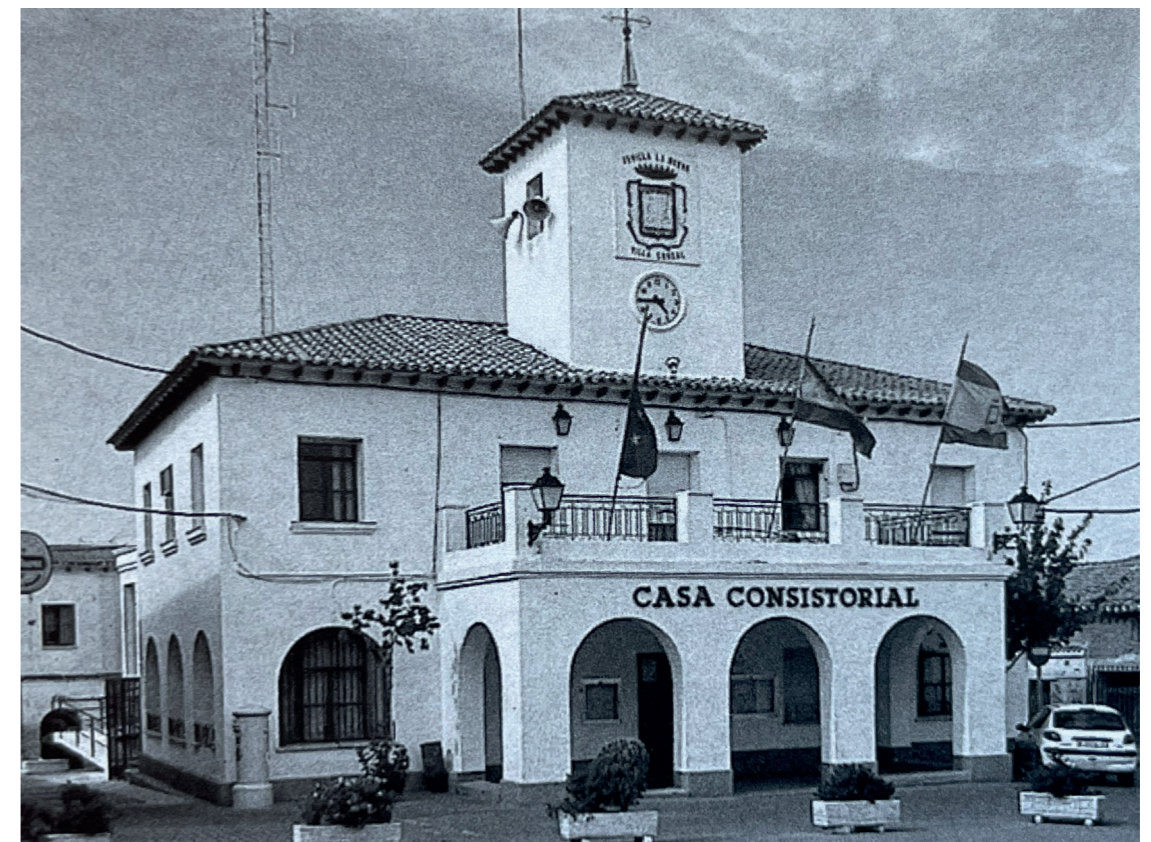
Ayuntamiento, año 2000. Fotografía: José Manuel Ablanado. En: Arquitectura y desarrollo, 2004. Fuente: Centro de Documentación de Medio Ambiente y Ordenación del Territorio.
