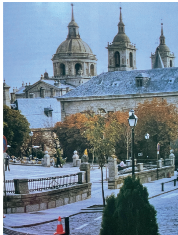
Plaza de la Constitución. En: Plazas con historia, 2002. Fuente: Centro de Documentación de Medio Ambiente y Ordenación del Territorio.
