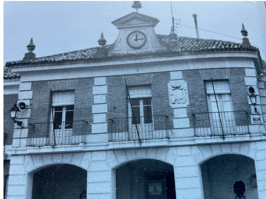
Fachada Ayuntamiento antiguo. En: Arquitectura y desarrollo, 1999. Fuente: Centro de Documentación de Medio Ambiente y Ordenación del Territorio.
