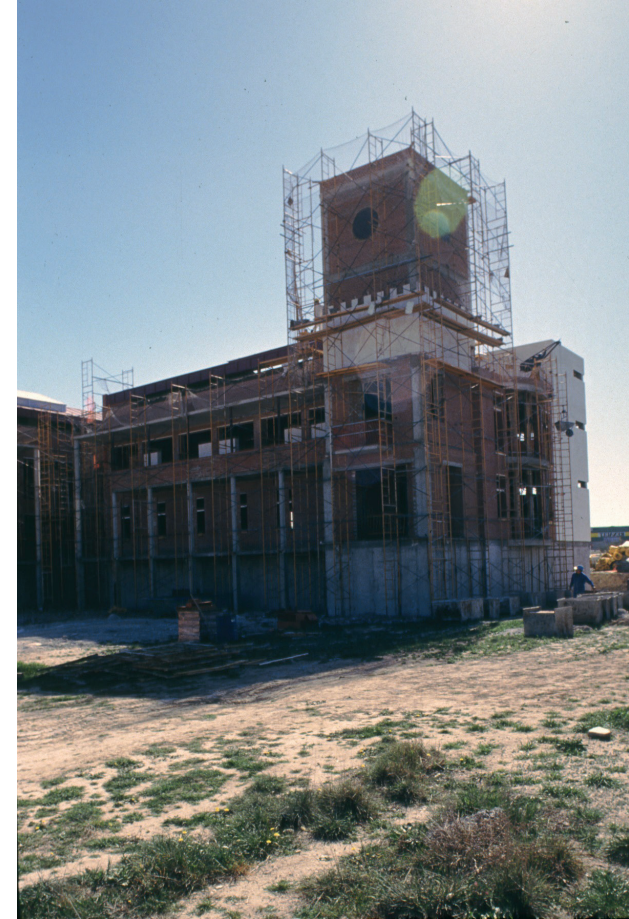
Construcción ayuntamiento nuevo, 1995. Fotografía: José Manuel Ablanado. Fuente: Centro de Documentación de Medio Ambiente y Ordenación del Territorio.
