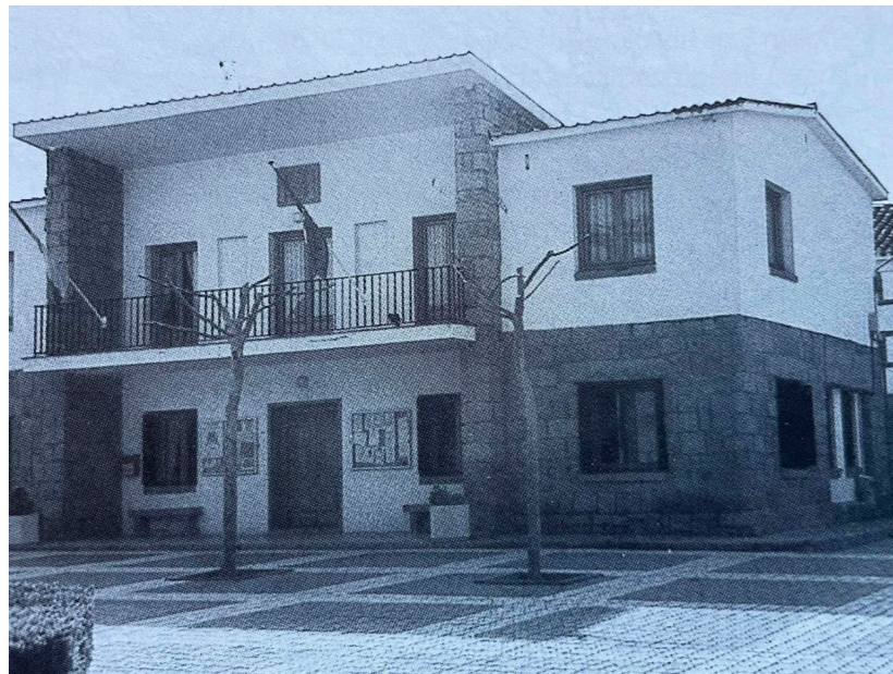
Ayuntamiento. Fotografía de Virginia Torres. En: Arquitectura y desarrollo, 1991. Fuente: Centro de Documentación de Medio Ambiente y Ordenación del Territorio.
