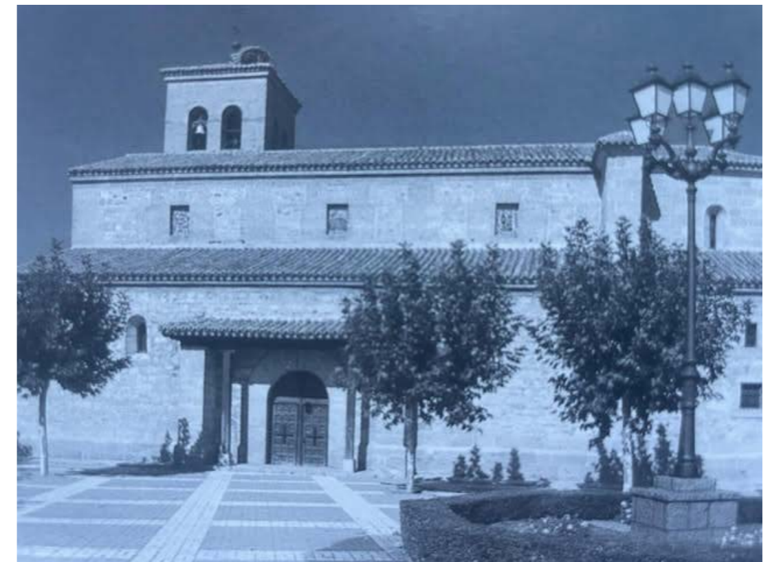
Fachada sur de la iglesia de San Juan Evangelista. Fotografía de Actividades y Servicios Fotográficos. En: Arquitectura y desarrollo, 1999. Fuente: Centro de Documentación de Medio Ambiente y Ordenación del Territorio.
