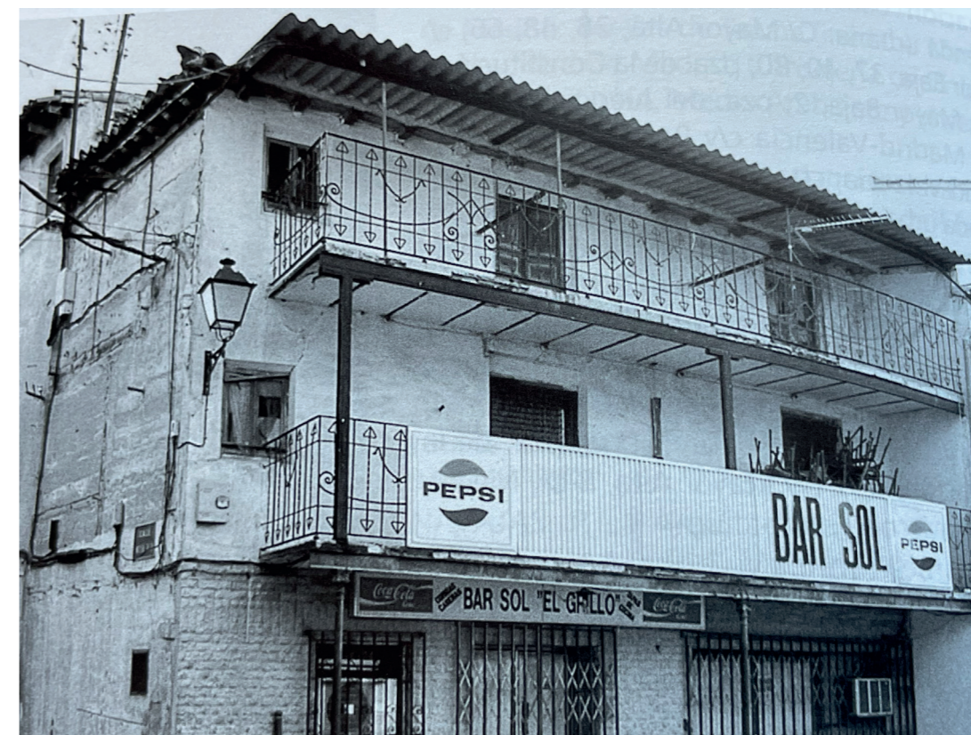
Vivienda en la plaza de la Constitución. En: Arquitectura y desarrollo, 2004. Fuente: Centro de Documentación de Medio Ambiente y Ordenación del Territorio.
