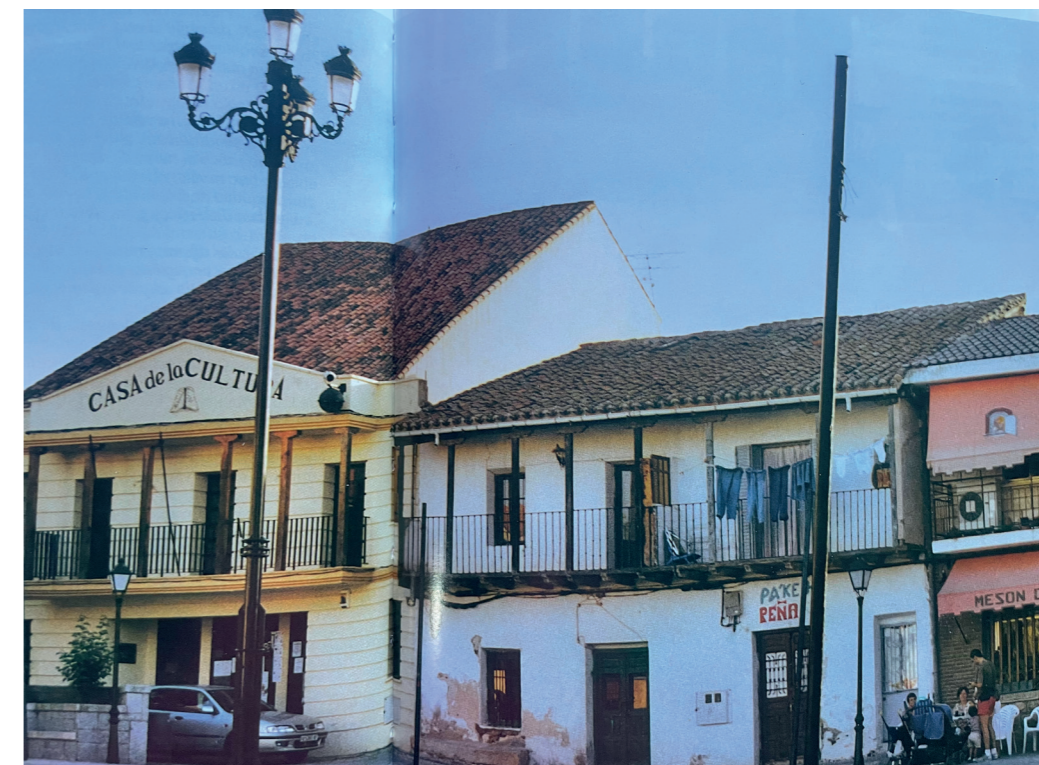
Plaza. En: Plazas con historia, 2002. Fuente: Centro de Documentación de Medio Ambiente y Ordenación del Territorio.
