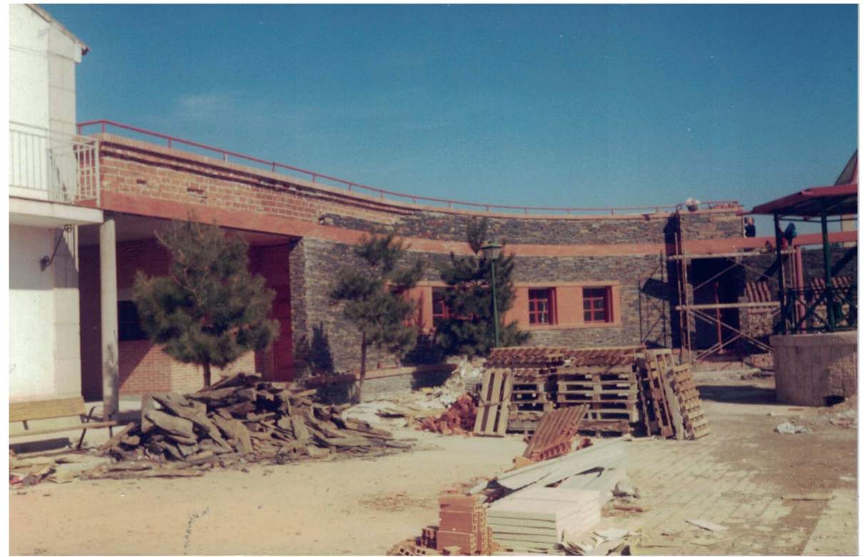
Obras de remodelación en la plaza de la Constitución, sin fecha. Fuente: Ayuntamiento de Patones.
