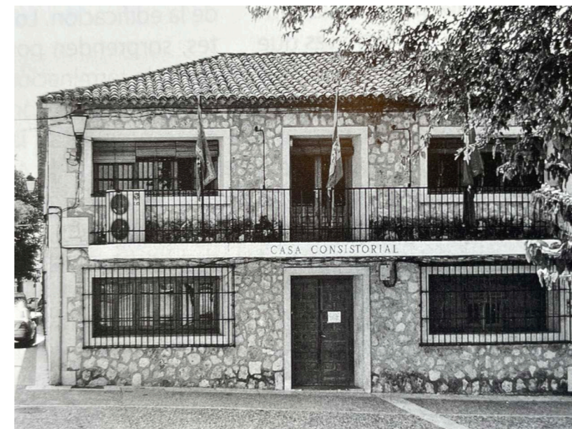
Ayuntamiento en plaza de la Iglesia. En: Arquitectura y Desarrollo, 2009. Fuente: Centro de Documentación de Medio Ambiente y Ordenación del Territorio.
