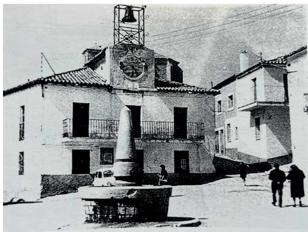
Ayuntamiento antiguo y fuente de la Soledad hacia 1965. En: Arquitectura y desarrollo, 2009. Fuente: Centro de Documentación de Medio Ambiente y Ordenación del Territorio.
