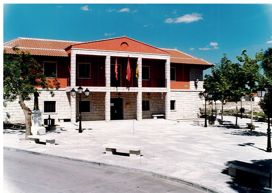
Ayuntamiento, 1992-93. Fuente: Ayuntamiento de La Cabrera.
