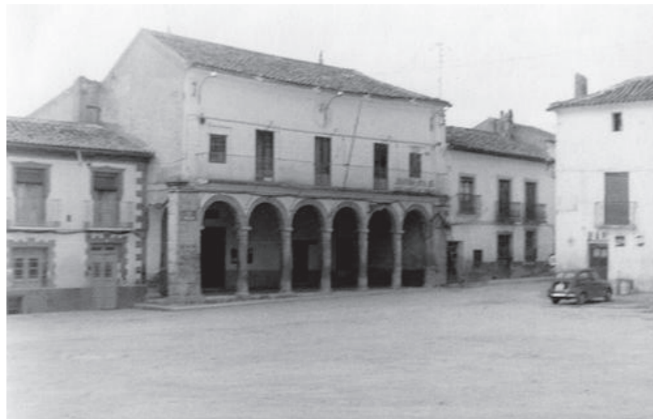
Ayuntamiento tras reforma en 1960. Fuente: Archivo Regional de la Comunidad de Madrid
