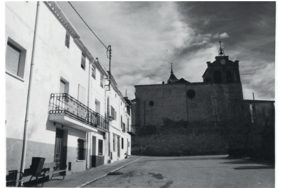
Iglesia y plaza. En: Información, clasificación y normativa de la zona sureste de los cascos urbanos de la Comunidad de Madrid, 1984
