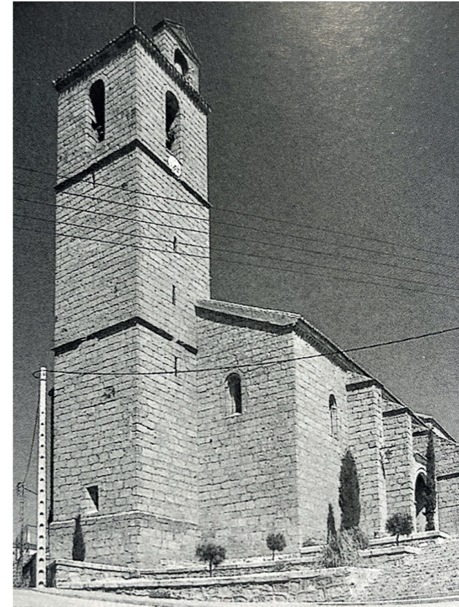
Iglesia de San Esteban Protomártir. Fotografía: Actividades y Servicios Fotográficos. En: Arquitectura y desarrollo, 1999. Fuente: Centro de Documentación de Medio Ambiente y Ordenación del Territorio.
