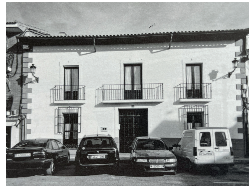
Vivienda en Plaza Mayor esquina calle del Cristo. Fotografía: Miguel Ángel Vega. En: Arquitectura y desarrollo, 2009. Fuente: Centro de Documentación de Medio Ambiente y Ordenación del Territorio.
